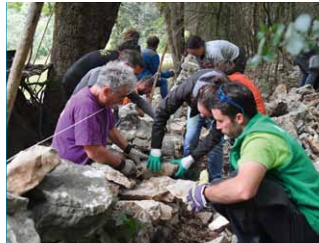
Chantier de pierres sèches. © Photo 07.
